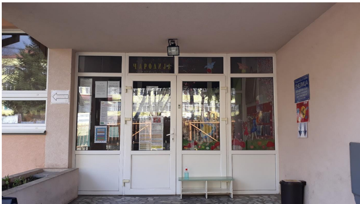
Slika 2 – Ulaz u postojeći objekat
